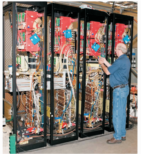
图 8 基于 SiC 的 13.8 kV/1 MVA SSPS [18]
